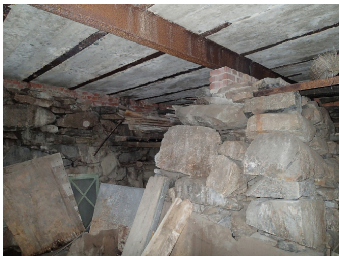
Ladugårdens betonggolv bärs upp av järnbalkar som vilar på massiva stenfundament. Foto: Per Hallén 2014.
