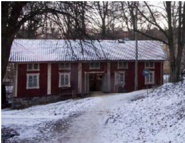
Idag används träbyggnaden till vänster i bild till stall, tidigare har det varit förrådshus och vedbod, vid någon tidpunkt även fårhus. Foto: Per Hallén 2014
