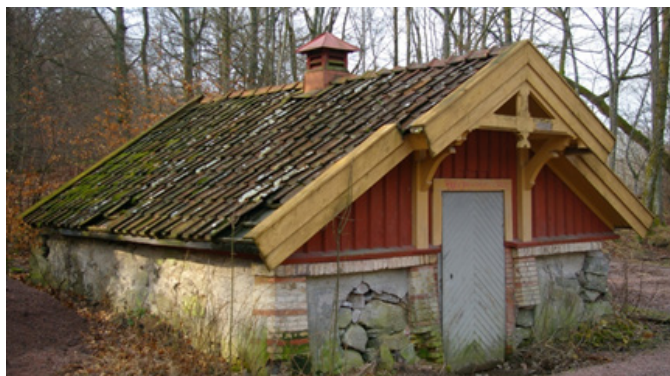
Jordkällaren sett från öster.
