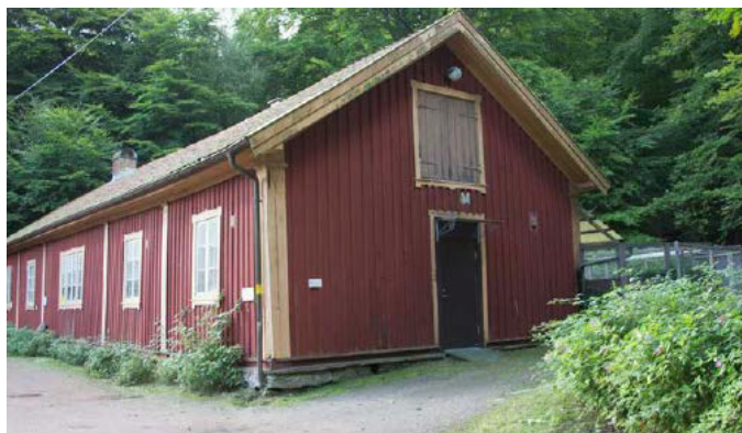
Ursprungligen användes byggnaden till vagnhästar och finare vagnar. Det fanns även en bostadsdel i huset. Under 1900-talet var byggnaden delvis garage. Idag hyrs byggnaden ut och används till hönshus. Foto: Per Hallén 2014
