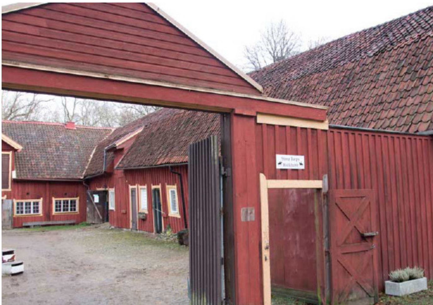
Portarna in till gårdsplanen är utformade på samma sätt som när anläggningen var ny 1851. Längst bort syns ladugården och till höger i bild den södra flygeln. Den norra flygelbyggnaden revs 1974. Foto: Per Hallén 2014
